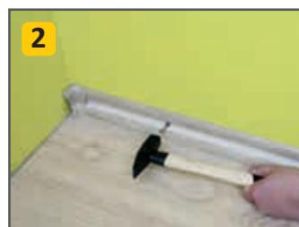
Montaż listwy do ściany z nałożonym narożnikiem wewnętrznym.
