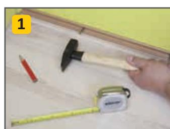
Przycięcie na wymiar i zamontowanie dolnej części listwy do ściany.
