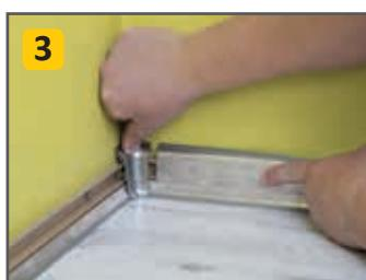
Przyłożenie narożnika, zamontowanie i wsunięcie górnej części listwy.
