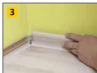
Przycięcie i montaż górnej części listwy (przycięcie po 7 mm z każdej strony ze względu na precyzyjne dopasowanie dekoru).
