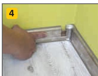
Montaż pozostałych części listwy, łączników i zakończeń.
