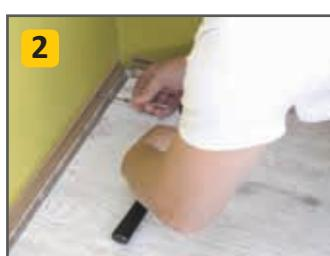
Montaż kolejnej dolnej części listwy na ścianie prostopadlej.
