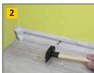
Montaż listwy do ściany z nałożonym narożnikiem wewnętrzny.
