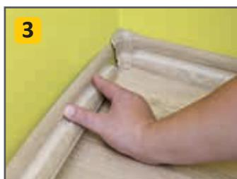
Montaż listwy na prostopadłej ścianie z wcześniejszym wsunięciem listwy w narożnik.
