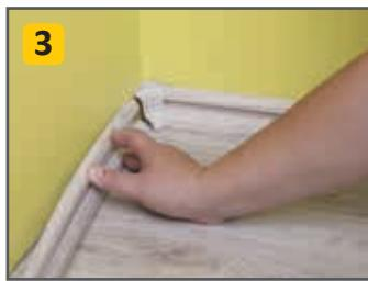
Montaż listwy na prostopadłej ścianie z wsunięciem listwy w narożnik.
