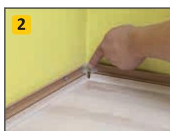
Montaż kolejnej dolnej części listwy na ścianie prostopadłej i montaż klipsa.
